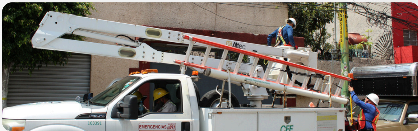
Figura 2 trabajo en campo
