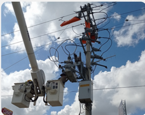
Figura 1 trabajo en campo
